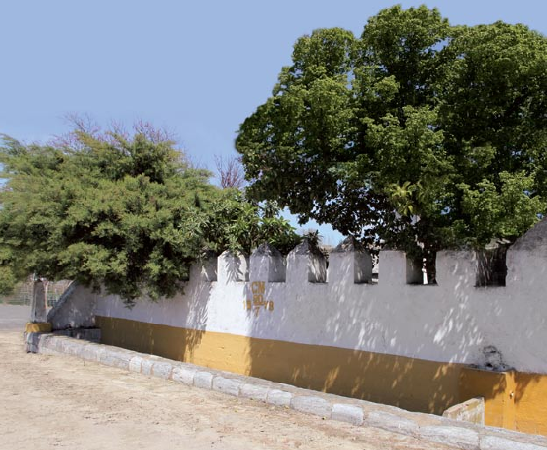
FIG. 2 Chafariz de Santa Clara. Teve obras em 1875. Observa-se, atrás, a parede com ameias e, à esquerda, o obelisco. O letreiro e as armas da cidade, diz Túlio Espanca, terão sido recolhidos ao Museu. Foto de Miguel Barriga
