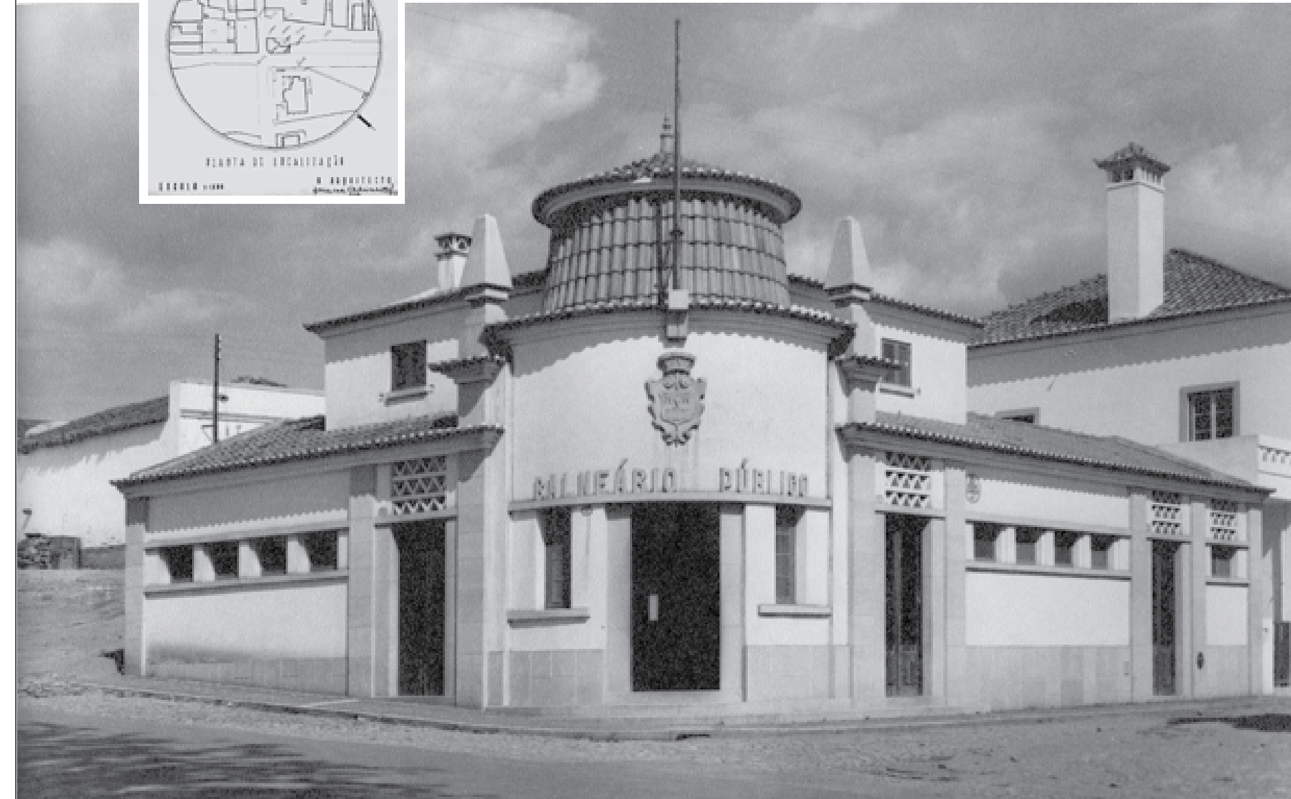
FIG. 71 O Balneário Público, depois de concluído. Am, B 134.
