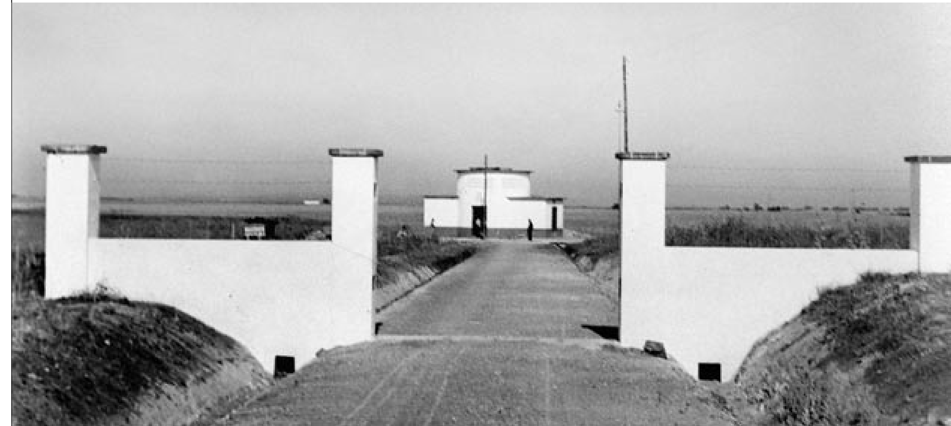
FIG. 63 Entrada para a Central elevatória das Terras Frias e captação de águas. AM B327.
