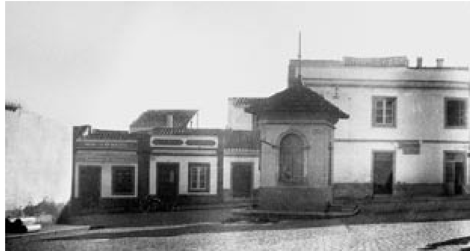
FIG. 43 O marco fontanário do Terreiro dos Valentines, já em degradação. AM, NB 311.
