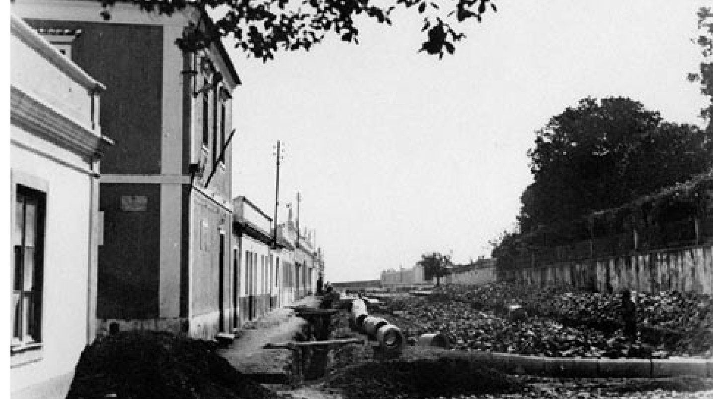
FIG. 56 Canalização de água na R. Afonso Henriques, junto ao muro do Jardim Público, em 1949. AM, B541.
