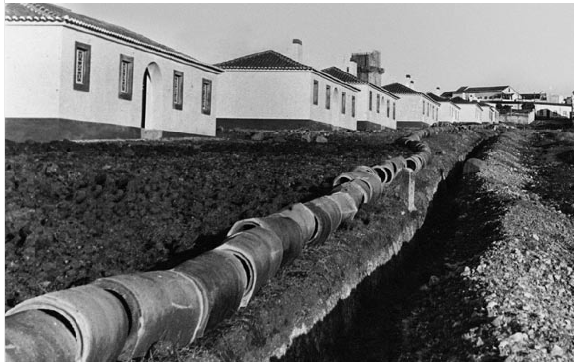
FIG. 79 Colocação de esgotos no Bairro da Apariça, em 1948. AM B5482.
