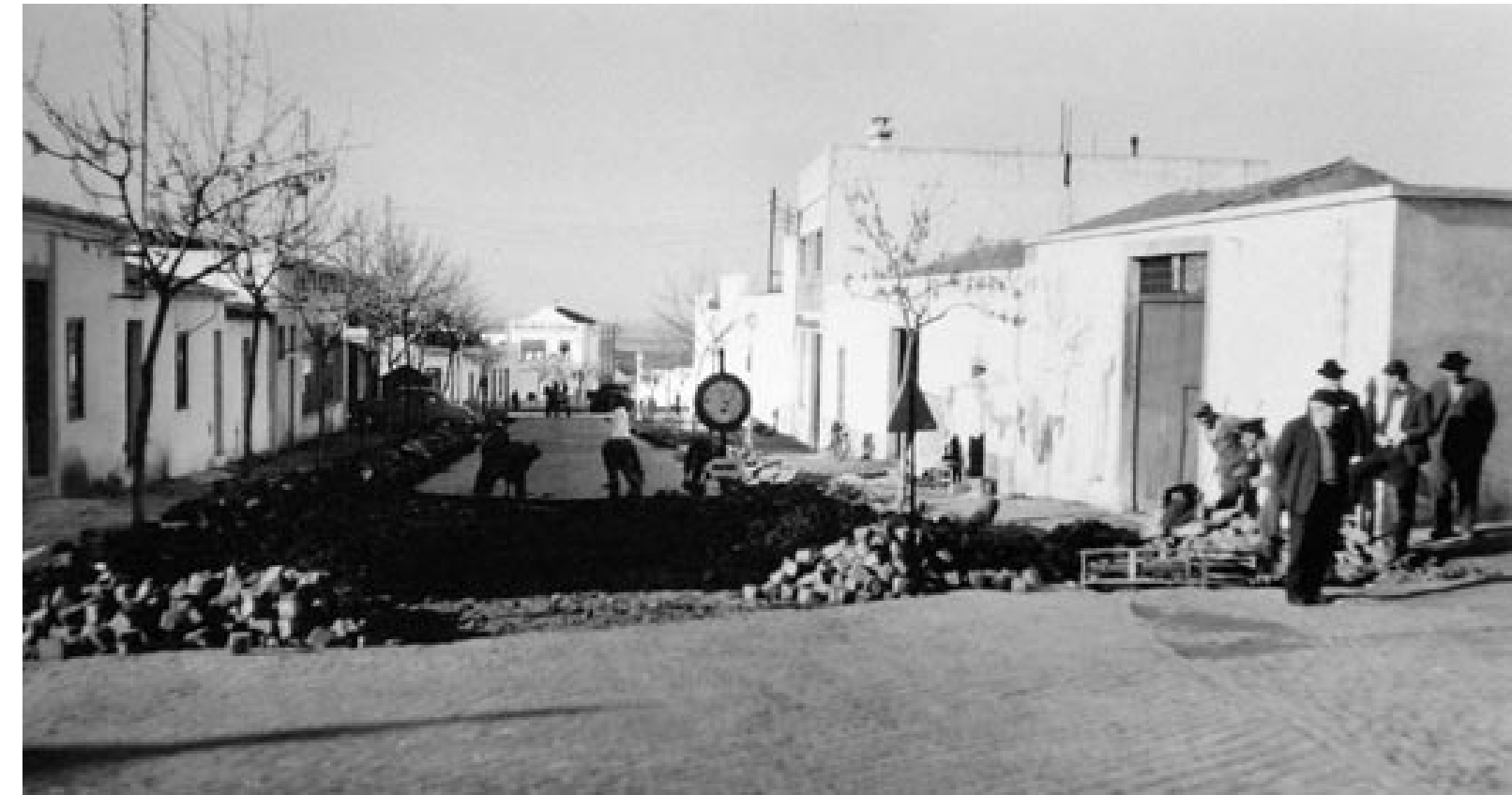
FIG. 61 Obras de remodelação da canalização na Rua de Lisboa em 1959. AM B5502.
