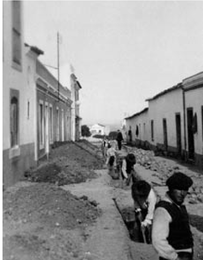
FIG. 60 Obras de remodelação da canalização na Rua de Lisboa em 1959. AM, B5501.
