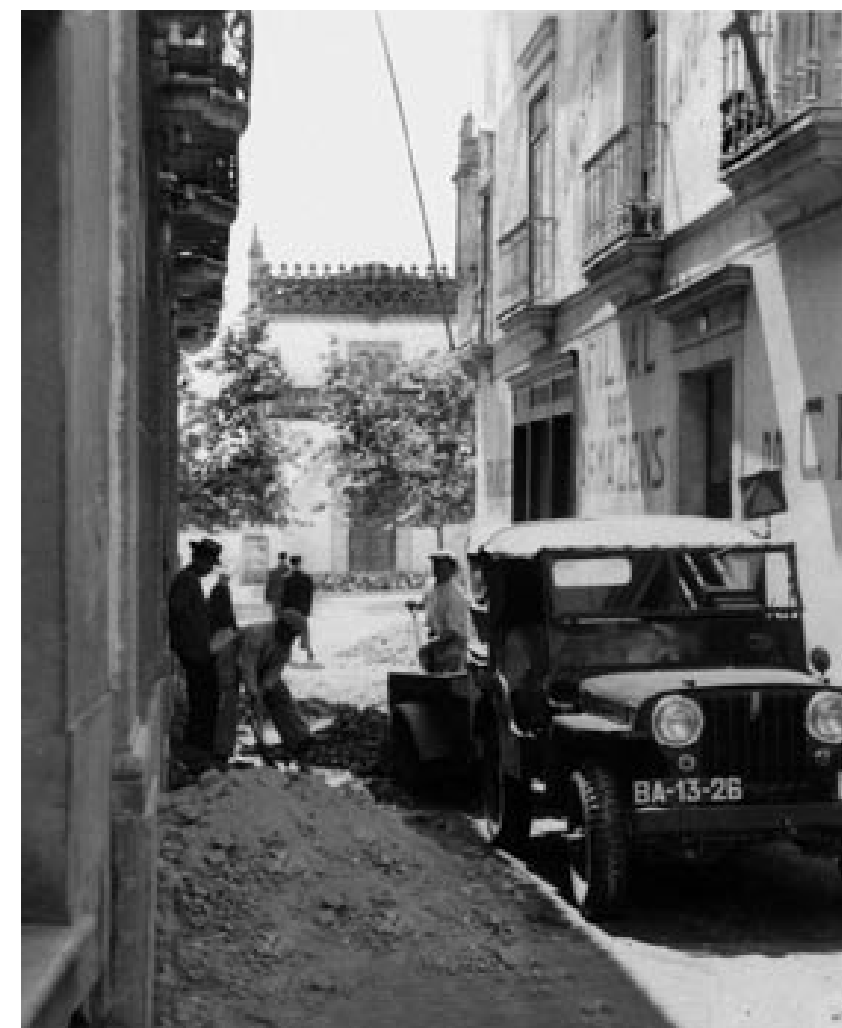
FIG. 75 Abertura de valas na Rua dos Infantes. AM B5129.
