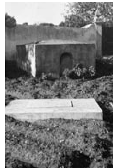
FIG. 23 Estruturas do depósito de água do Tanque dos Cavalos, dentro de uma das quintas ali existentes. AM, B325.
