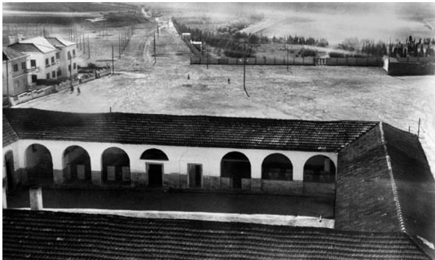
FIG. 17 Em primeiro plano, o antigo matadouro. Ao fundo vemos os muros da propriedade onde hoje se encontra a Piscina Municipal e o Pavilhão Desportivo. Do lado direito, a Rua Afonso de Albuquerque, sendo a última casa o Colégio de Nossa Senhora da Conceição. Se seguíssemos junto ao muro iríamos ter ao Poço Largo e à antiga estrada de Mértola, cujo percurso se vê pelas árvores que lhe estão próximas. AM, A5111.
