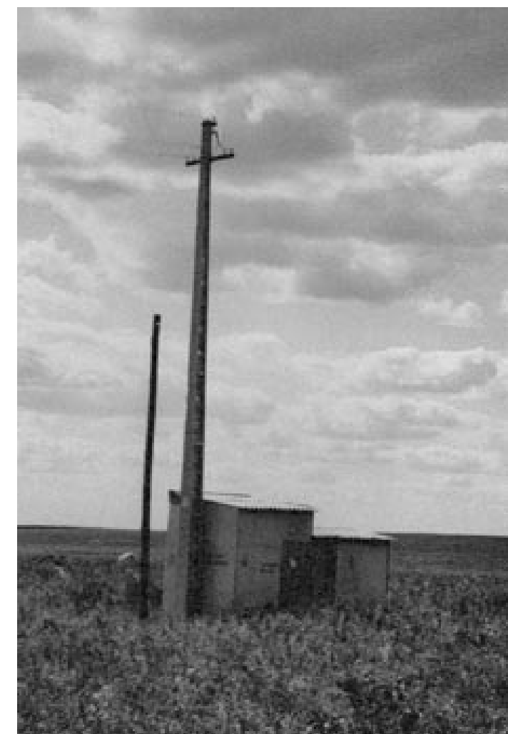
FIG. 76 Estação provisória de um dos novos furos de captação de águas. AM, B324.
